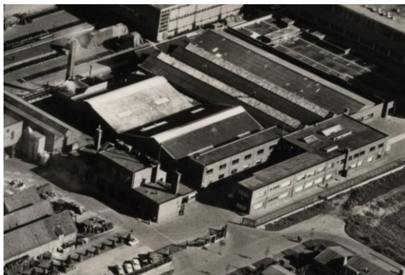
Detail van het fabriekscomplex van Balatum NV circa 1960 (ansichtkaart, collectie J. Hoegee). De voormalige Tapijtfabriek Trio NV valt nog te herkennen.
