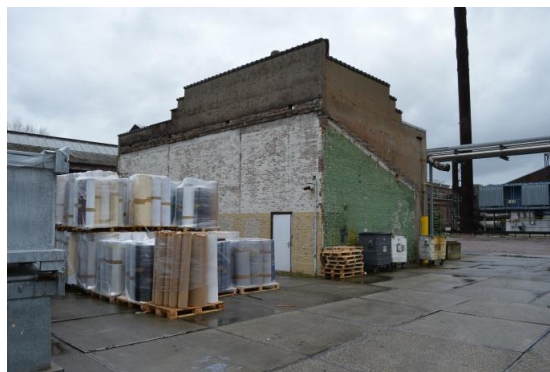
Overzicht van gebouw 37, gezien vanuit het zuidoosten.
