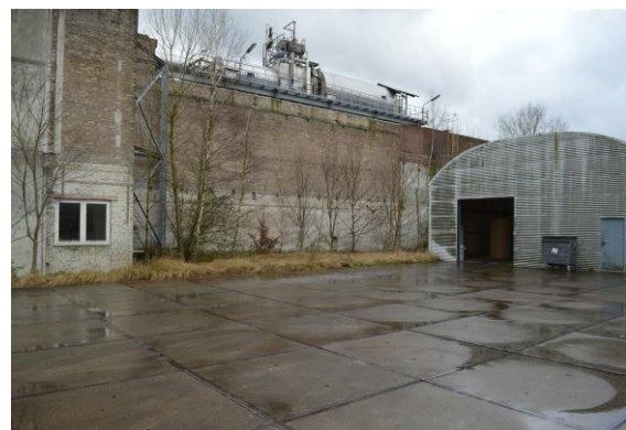
Gebouw 10, westelijke zijgevel na sloop van belendingen.
