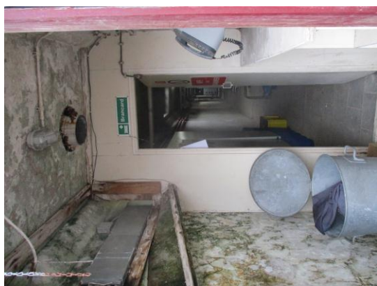
13. Lekkage en algvorming in de gang. (gebouw 2 gang oostzijde)
