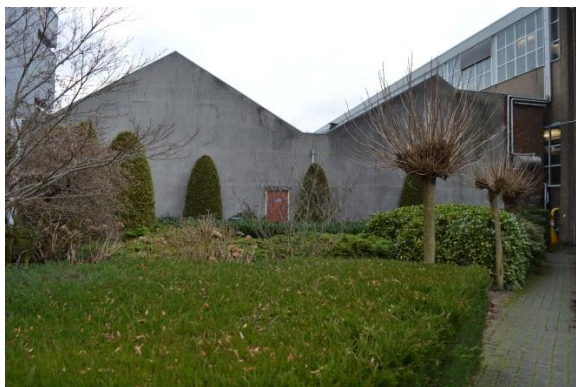
Kopgevel (zuidgevel aan de Rokerijweg).
