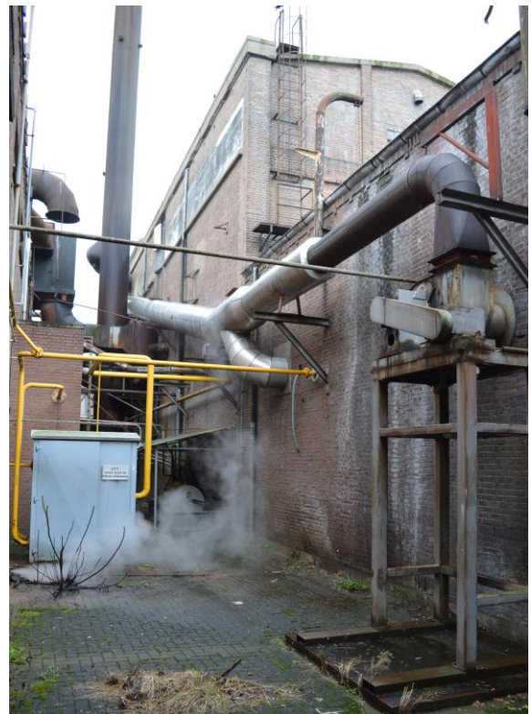
De 'fabrieksgang' tussen de gebouwen 10/11 en 4/25/28.
