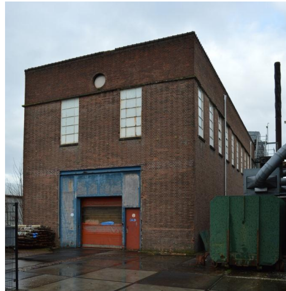
Gebouw 10, zuidgevel van het zuidelijk deel uit 1950.
