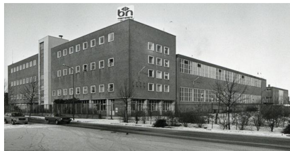
Voorgevel van het voorgebouw omstreeks 1981 (SAGV beeldbank, nr. SAGV236_D1_4477).
