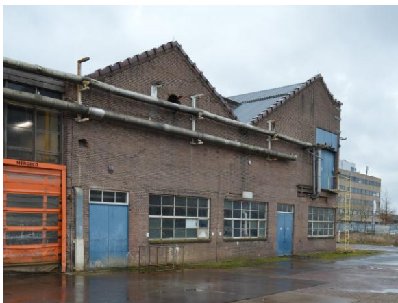
Gebouwen 10 en 11, noordgevel van de uitbreiding 1940. Gebouw 11 heeft een asymmetrische doorsnede, die zich ook aftekent in de noordgevel.
