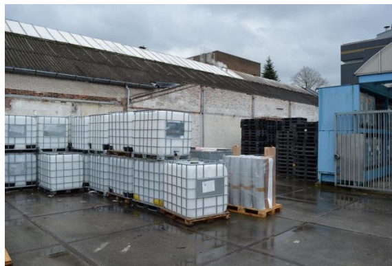
Zijgevel met rest van gesloopte, oude hoofdgebouw van NV Hollandse Huiden- en Ledermaatschappij uit 1936, waarvan de kappen haaks aansloten (zie gebouw 37).
