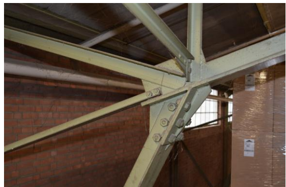
Detail van een kniespant, deels met klinknagels en deels met schroefbouten.
