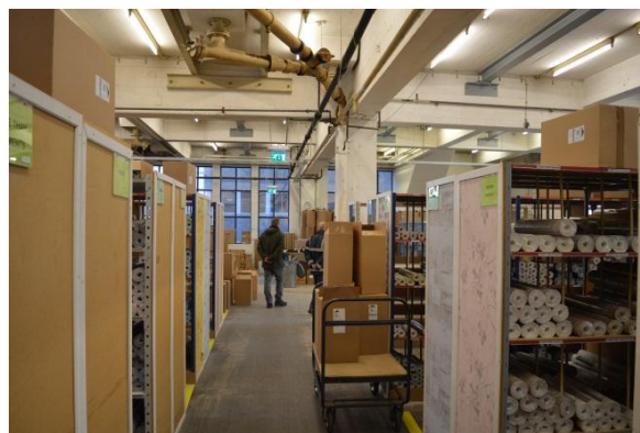
Betonconstructie op de eerste verdieping.
