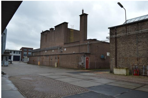
De achtergevel van gebouw 2.
