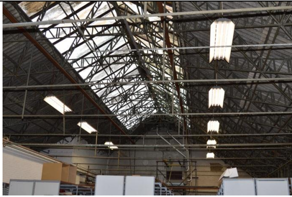
Kapconstructie met kruisende diagonale spanten (1947).
