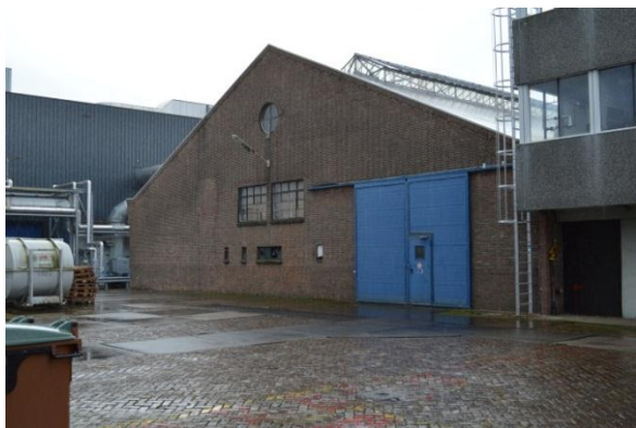
De noordelijke kopgevel van de oostelijke hal, gebouw 32A (1949).
