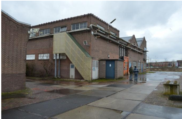
De noordgevel van de gebouwen 25, 10 en 11.
