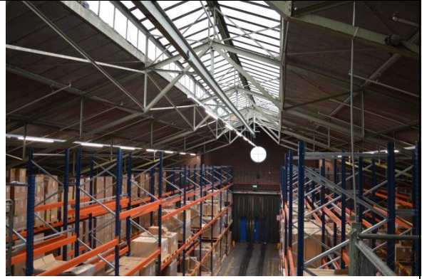
Interieur van gebouw 32D, de westelijke hal (1953).
