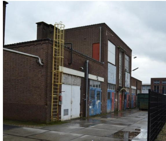
De voorgevel van gebouw 2.
