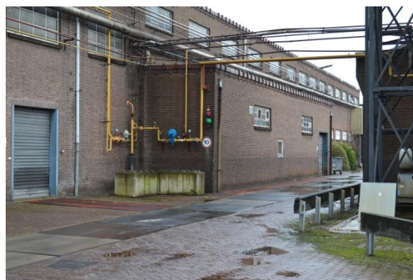
Aanbouw tegen de westgevel van gebouw 28 (1955).
