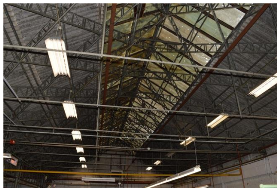
Kapconstructie met kruisende diagonale spanten (1947).
