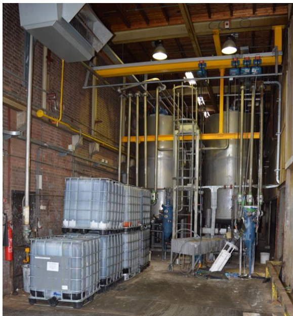
Het noordelijke deel van de 'fabrieksgang' is in 1968 overbouwd als viltmagazijn.
