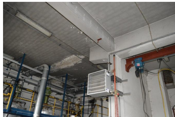
Betonconstructie boven de begane grond. Het balkenstelsel draagt de middenpartij.
