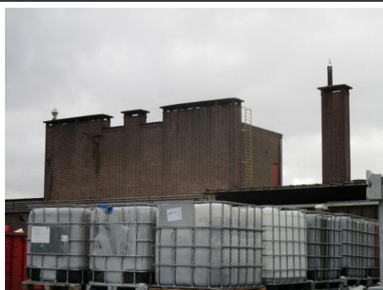
17. Gemetselde schoorstenen met afdekplaten. (gebouw 2 oostzijde)
