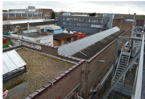
Dakaanzicht. De gevel aan de zijde van de fabriek is hoger opgetrokken (schermgevel).
