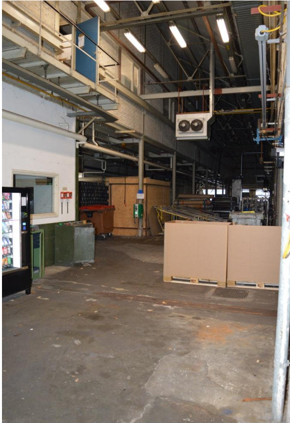
Gebouw 11, insteekverdieping met magazijn. Hier is een half poloncauspant herkenbaar.
