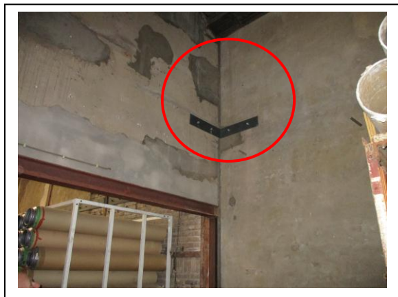
19. Later aangebrachte constructieve versterking tussen wanden (gebouw 11)
