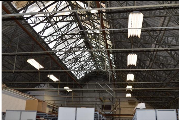
Kapconstructie met kruisende diagonale spanten (1947).
