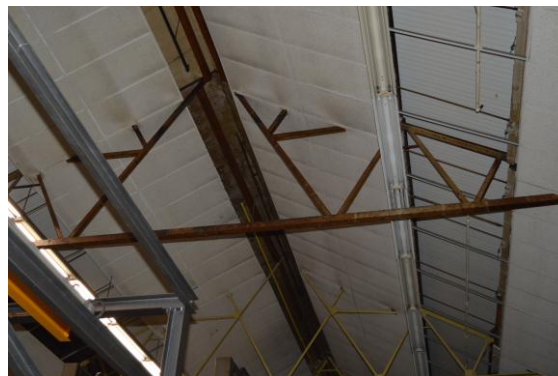
Verschillende spanten in gebouw 10, waarvan de voorste in de uitbreiding uit 1940 en de achterste in het gedeelte uit 1933-'36.
