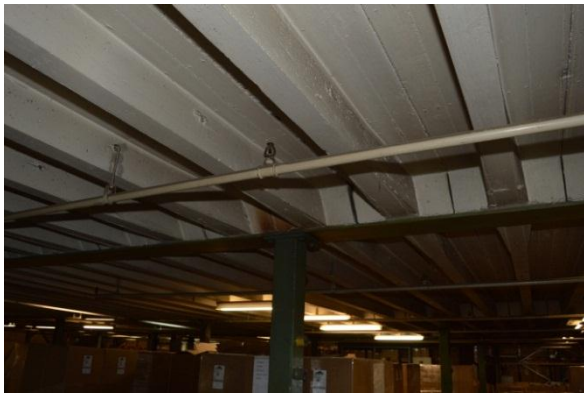
Constructie van de tussenverdieping in gebouw 32D, de westelijke hal (1953).
