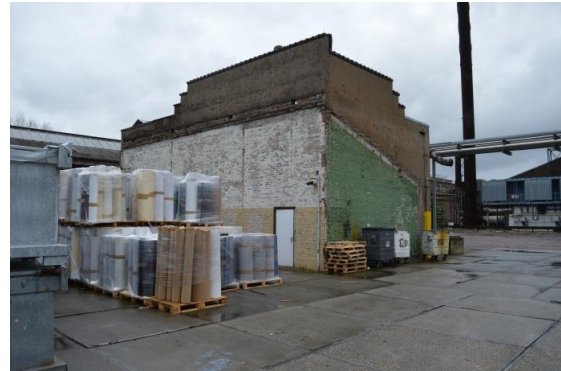
Overzicht van gebouw 37, gezien vanuit het zuidoosten.
