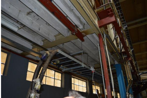
Betonconstructie van de tussenvloer.
