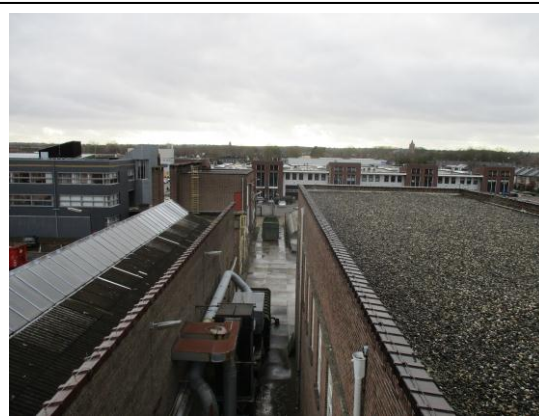
10. Bitumen gedekt plat dak voorzien van grindbelasting (gebouw 10B)
