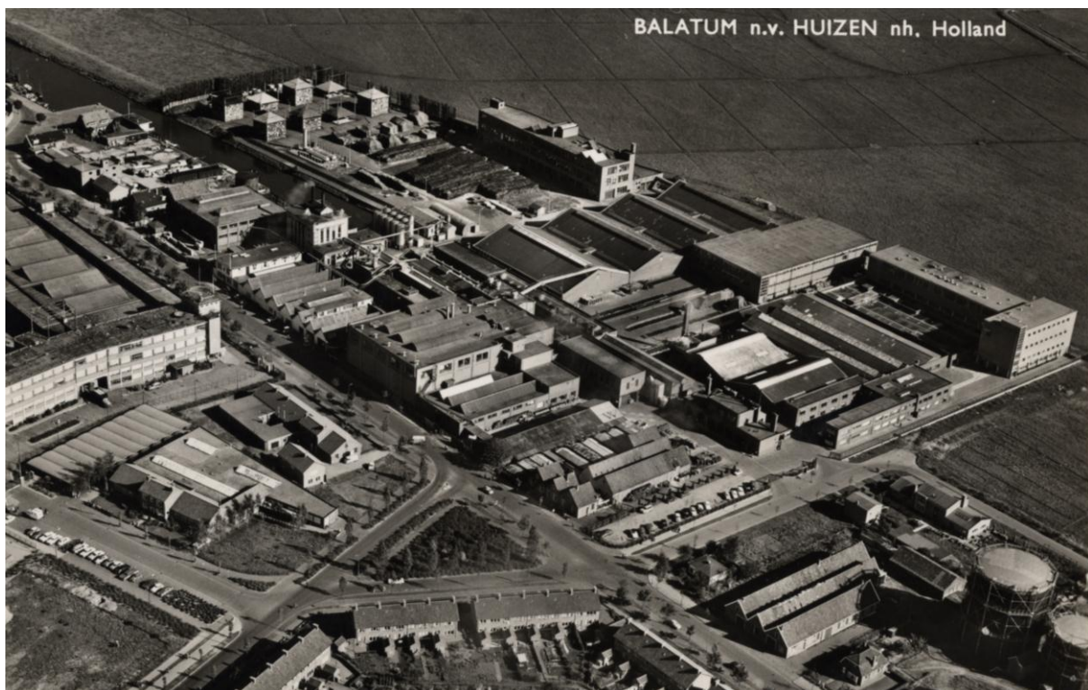
Luchtfoto van het fabriekscomplex van Balatum NV omstreeks 1960 (ansichtkaart, collectie J. Hoegee, https://www.flickr.com/photos/157991588@N03/ ). Op deze foto valt te zien dat gebouw 44 en nog slechts de helft van gebouw 45 zijn gerealiseerd.
