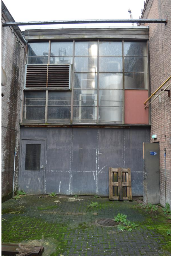
De zuidelijke kopgevel van gebouw 10c, gezien vanuit de 'fabrieksgang'.
