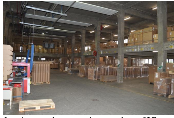
Interieur van het voorgebouw, gebouw 32E (1957). In het midden bevond zich een verdiepte laad- en losstraat. Ter weerszijden daarvan bevonden zich platforms.
