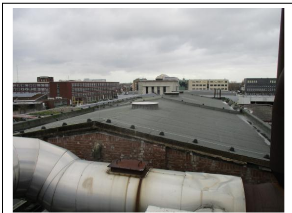
11. Recentelijk vernieuwd bitumen gedekt schuin dak (gebouw 10 richting noorden)
