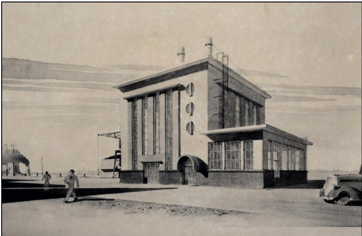
Het betonnen energiegebouw van de NV Balatum (foto: collectie J. Hoegge, https://www.flickr.com/photos/157991588@N03/ ). Dit gebouw dateert uit 1938/1939, de uitbreiding uit 1948/1949.
