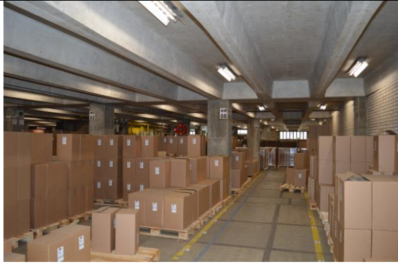
Interieur van de begane grond van gebouw 32B (1967-'68).
