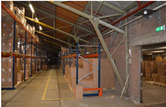
De 'knieen' van de kniespanten in gebouw 32C (1950).
