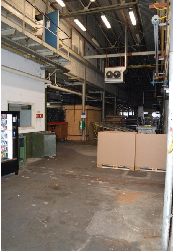
Gebouw 11, insteekverdieping met magazijn. Hier is een half poloncauspant herkenbaar.
