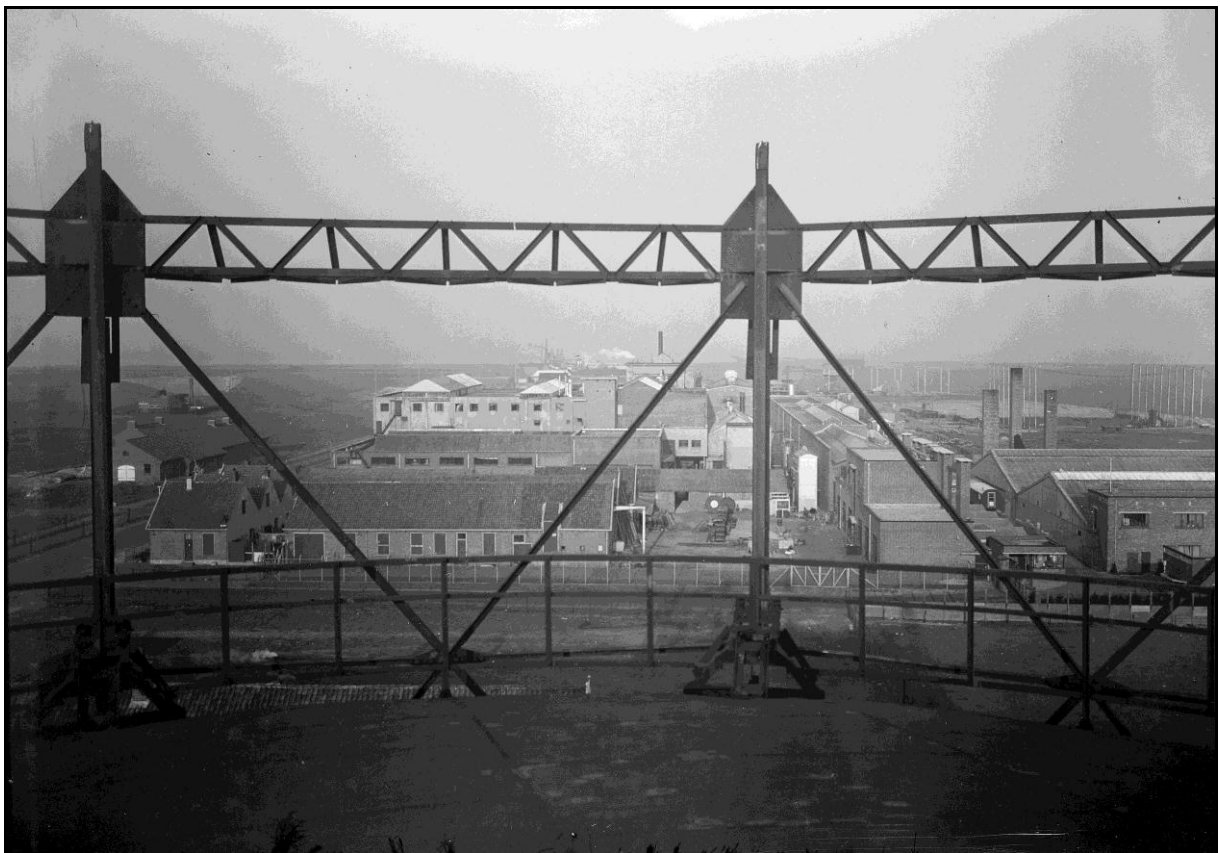
Overzicht van de fabriek van Balatum NV, gezien vanaf de gashouders van de gasfabriek, foto Jacques Stevens (sagvfoto-s-0244-002_ balamundi nov 1949).
