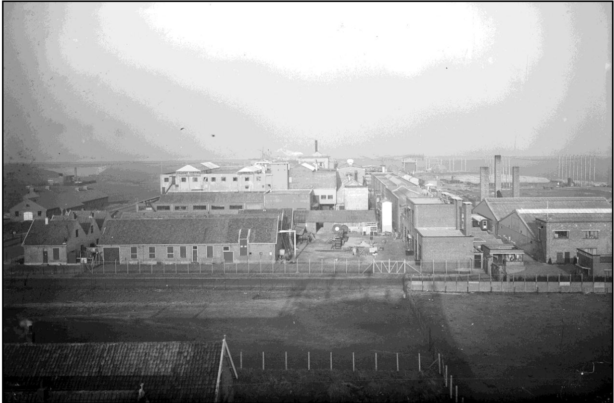
Overzicht van de fabriek van Balatum NV, gezien vanaf de gashouders van de gasfabriek, foto Jacques Stevens (sagvfoto-s-0244-001_ balamundi nov 1949).
