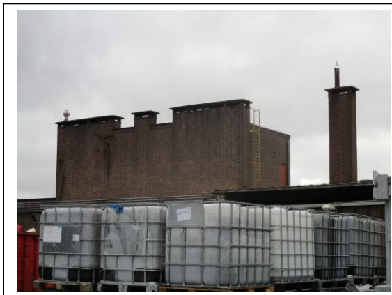
17. Gemetselde schoorstenen met afdekplaten. (gebouw 2 oostzijde)
