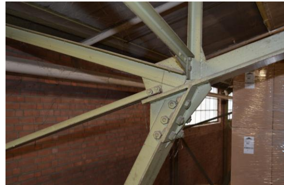
Detail van een kniespant, deels met klinknagels en deels met schroefbouten.
