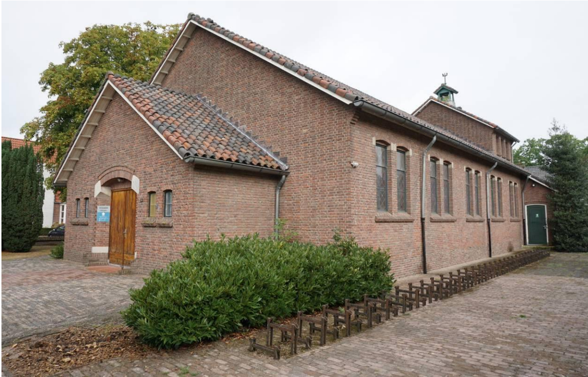
Het kerkgebouw met entreeportaal, schip, dwarsschip en dakopbouw boven de viering
