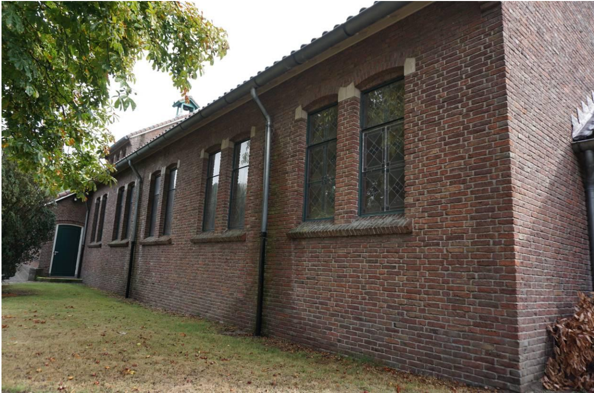
Westgevel van het schip
