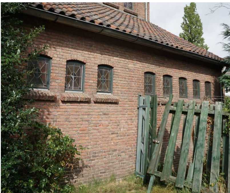
Oostgevel van het dwarsschip
