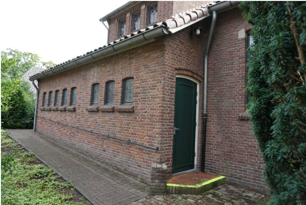
Zuidgevel en westgevel van het dwarsschip
