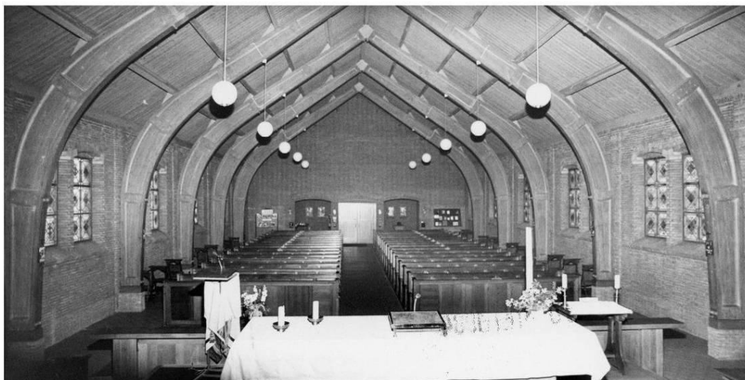
Het interieur in 1984 (SAGV236_D1_4676)
