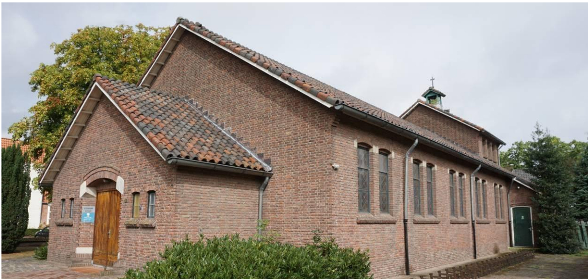
Zadeldaken op verschillende hoogtes
