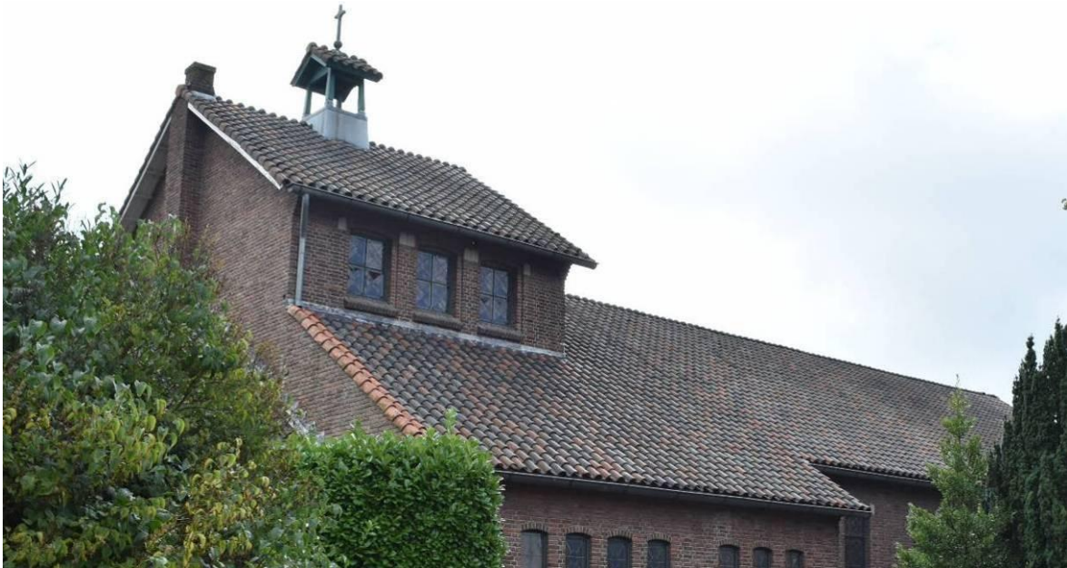
Noordgevel en westgevel van de dakopbouw boven de viering
