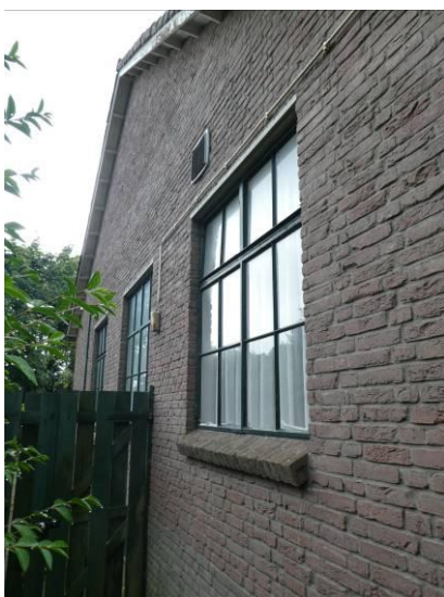
Noordgevel van de achteraanbouw
