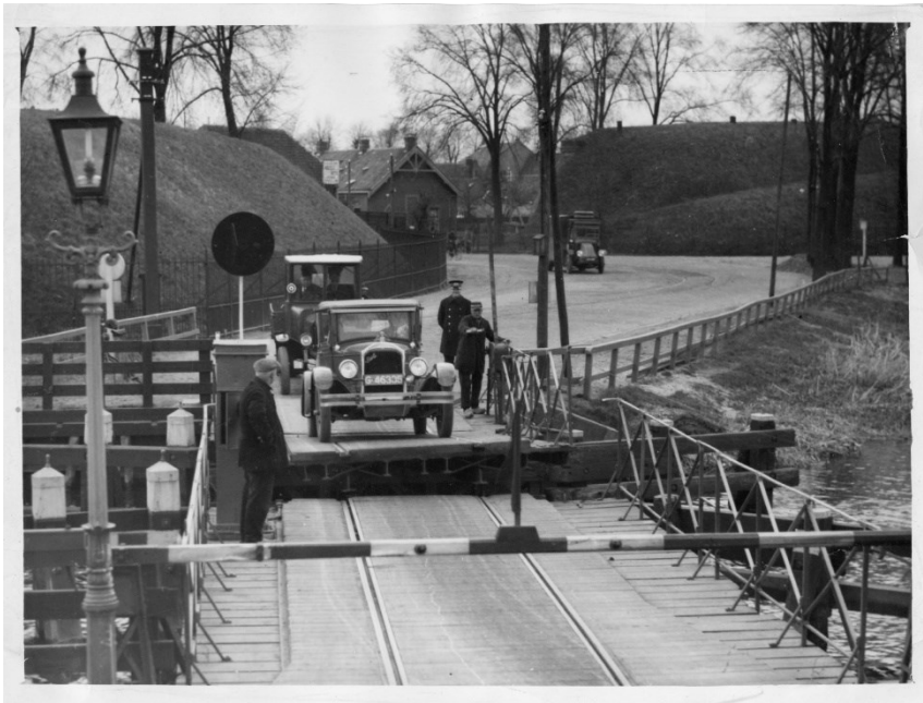
Naarderpoortbrug, net buiten Muiden (ca. 1925-1930) – de brug was dusdanig vaak opgehaald dat deze niet meer goed sloot en daardoor moest steeds een der wachtenden langzaam de brug oprijden om deze omlaag te duwen (N.V. Int. Persfoto Bureau Amsterdam) - SSAN092M (aanwinst 2021, nr.42)
