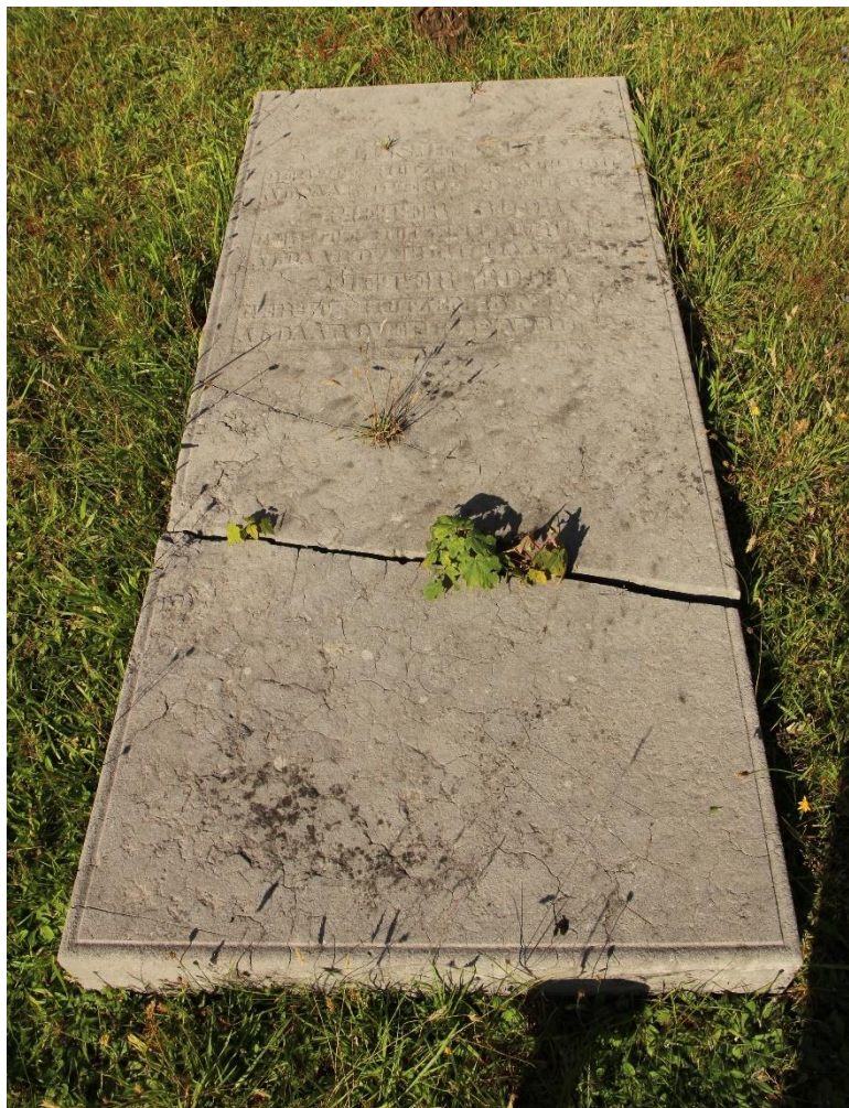
Afb. 21, Grafmonument 5-BON-31 verkeert in slechte staat. Herstel is noodzakelijk, maar in dit geval niet ingewikkeld. Herplaatsing op een betonplaat kan de levensduur van de zerk aanzienlijk verlengen.
