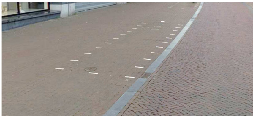
Figuur 5.3: Voorbeeld 'fietsparkeervakken' centrum Amersfoort
