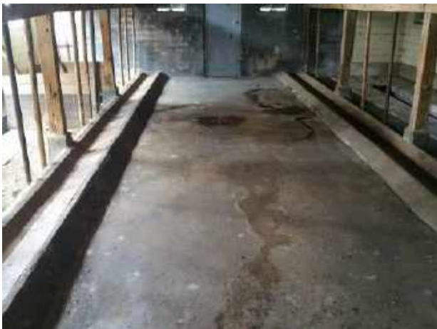
FB08: Gezien het bouwjaar en de gebruikte bouwmaterialen is er geen verwachting van asbestverdachte materialen onder de betonvloer.
