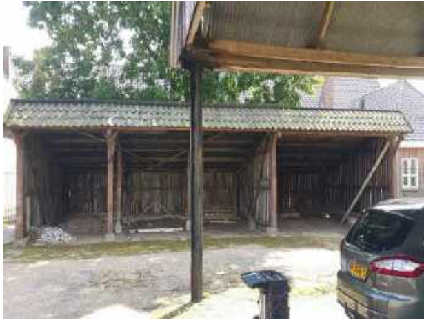
FB01: Overzicht afdak
