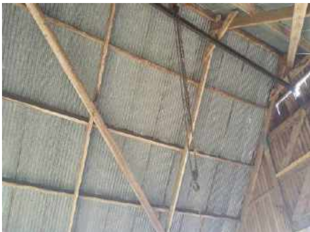
FB04: De hooibergen zijn afgewerkt met metalen golfplaten dakbeplating.
