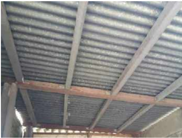
FB06: De carport is afgewerkt met golfplaten dakbeplating.
