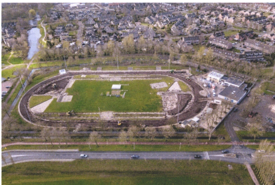
Foto Ton Kastermans: Luchtfoto renovatie atletiekbaan
