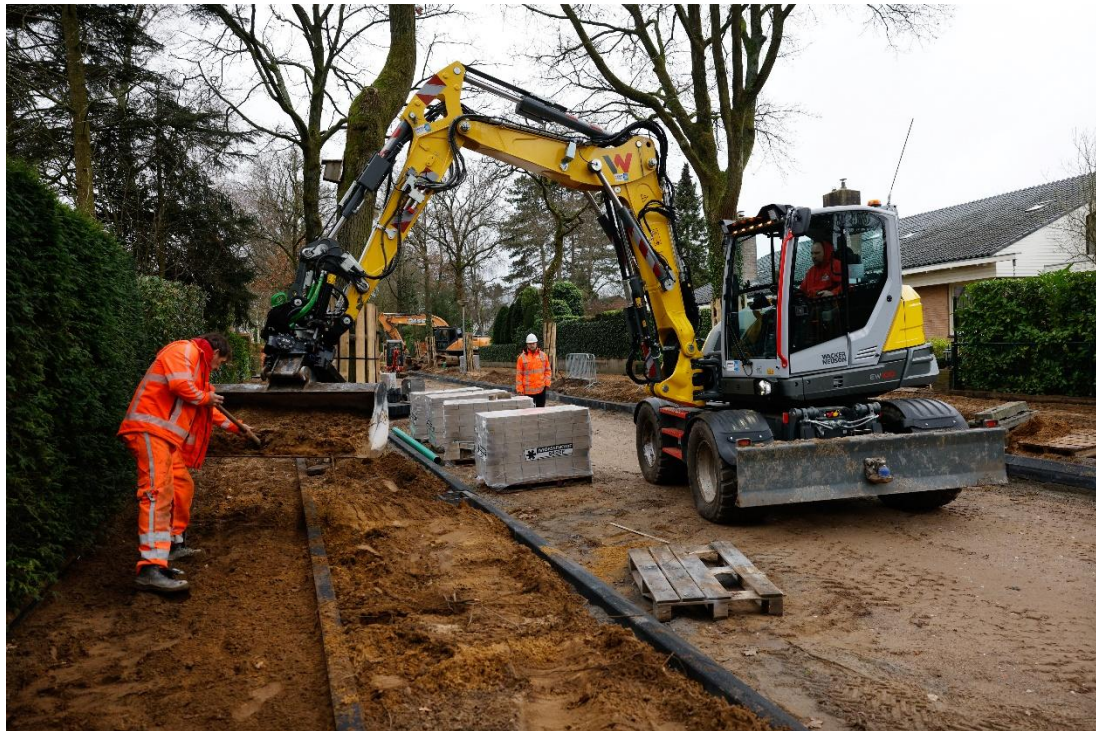
Figuur 4 Weg- en rioolwerkzaamheden
