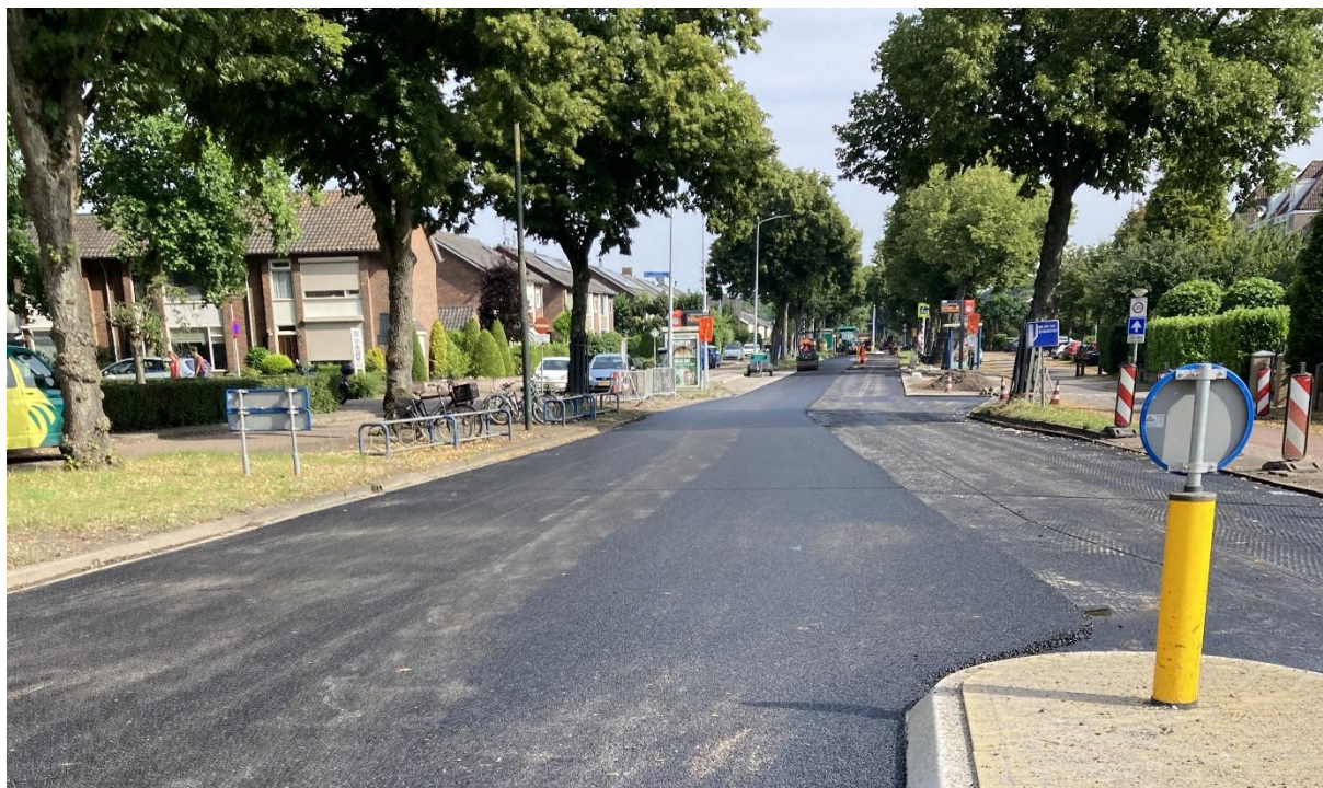
Figuur 9 Nieuw asfalt
