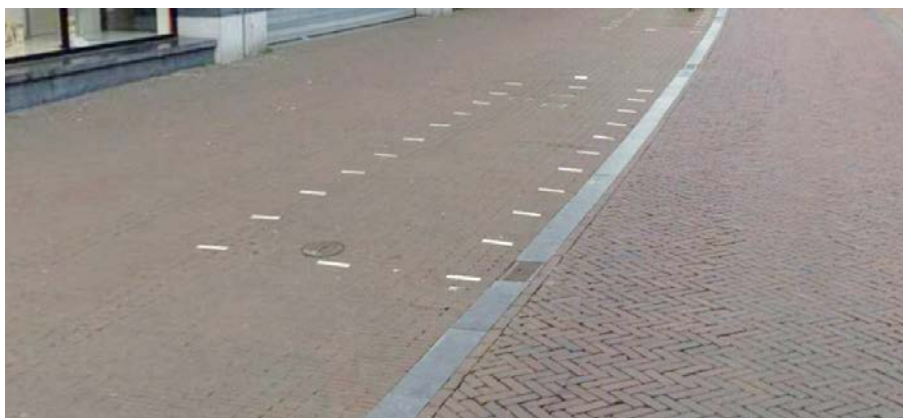
Figuur 5.3: Voorbeeld 'fietsparkeervakken' centrum Amersfoort
