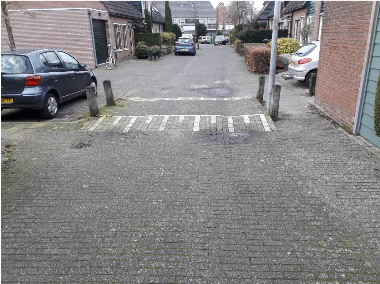
Drempel Dukdalf vanaf Westkade gezien
