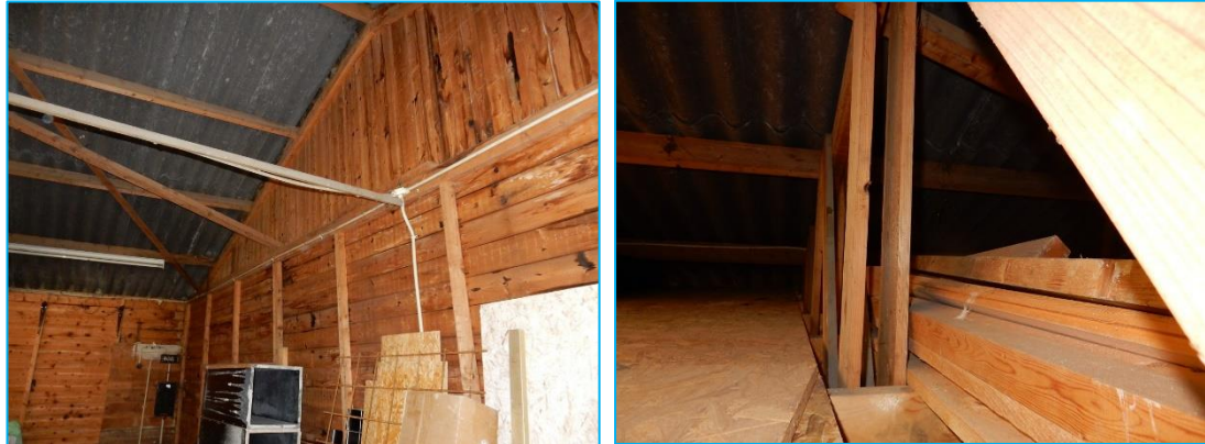
Foto's: Links; enkelwandige houten betimmering. Rechts; open ruimtes tussen de houten spanten.
