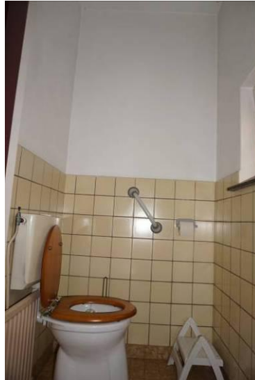
Toilet in de achteraanbouw
