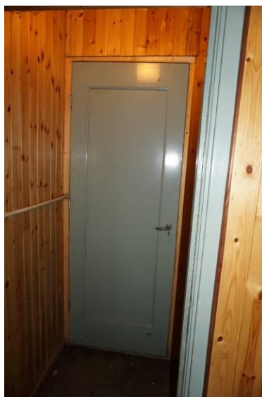
Voorhal in de kelder
