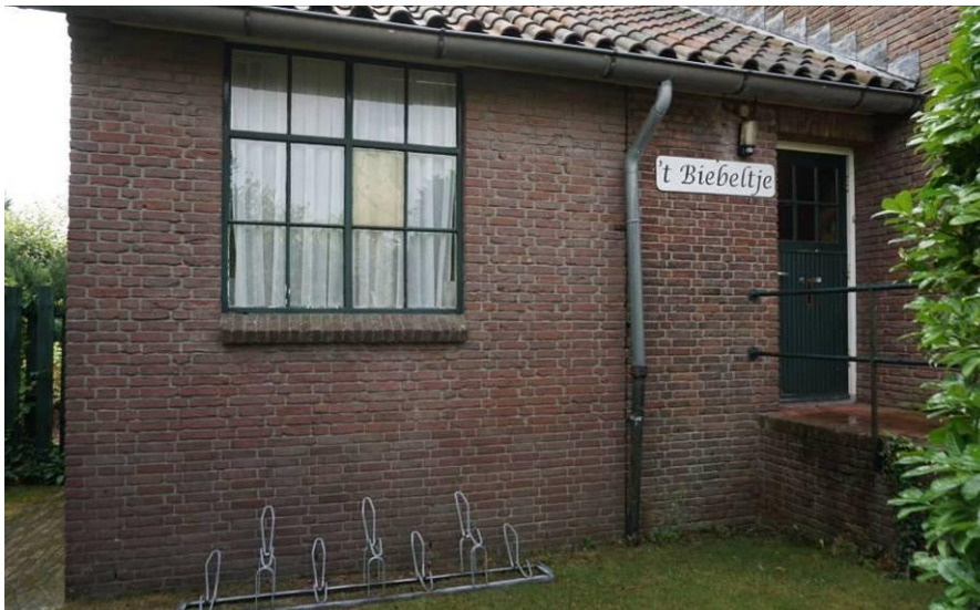
Westgevel van de achteraanbouw
