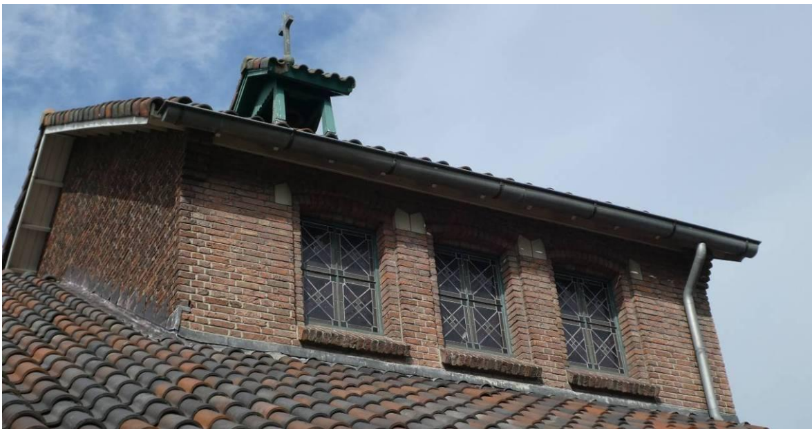
Zuidgevel en oostgevel van de dakopbouw boven de viering
