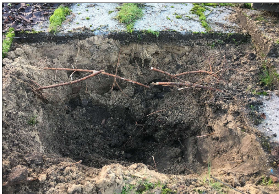
Figuur 2: Oppervlakkige opnamewortels ( \Phi 1 cm) onder verharding;
