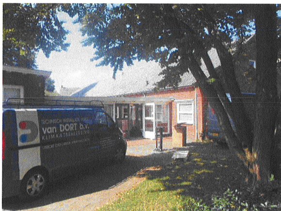
Toelichting bij foto 1: Het betreft de sanering van een asbesthoudende cementbuis in de cv-ruimte, de begane grond en op zolder, de sanering van asbesthoudende pakkingen en een asbesthoudende golfplaat in de cv-ruimte en een schoonmaakactie na aangetroffen asbest via kleefmonste
