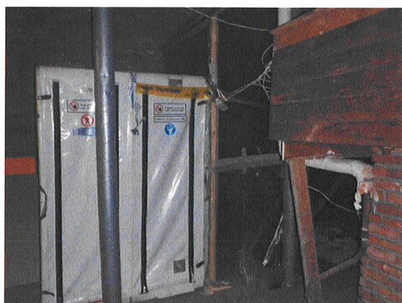
Toelichting bij foto 3: Op zolder is het containment te betreden via een 2-traps deco-unit.
