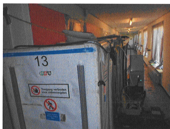
Toelichting bij foto 4: De 2-traps afvalsluis is geplaatst in een tijdelijke foliewand recht tegenover de deco-unit.
