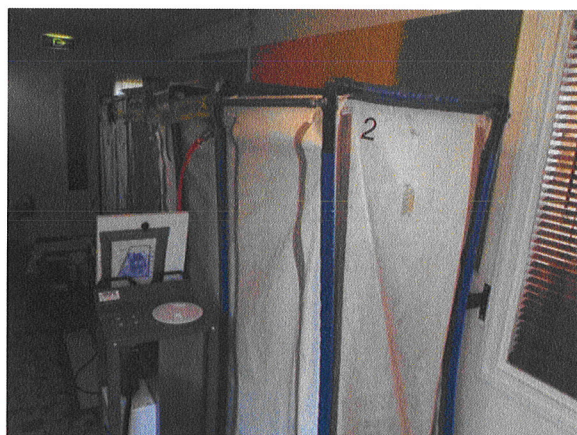
Toelichting bij foto 2: Het containment is te betreden via een 3-traps deco-unit welke geplaatst is in een tijdelijke foliewand in de gang voor de ingang naar de cv-ruimte op de begane grond.
