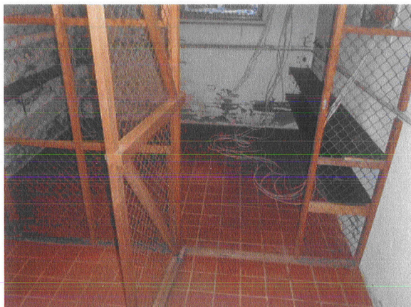
Toelichting bij foto 13: Het asbesthoudende stof in de cv-ruimte is verwijderd d.m.v. een schoonmaakactie.
