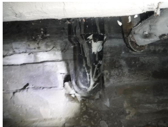
Asbesthoudende riolering
