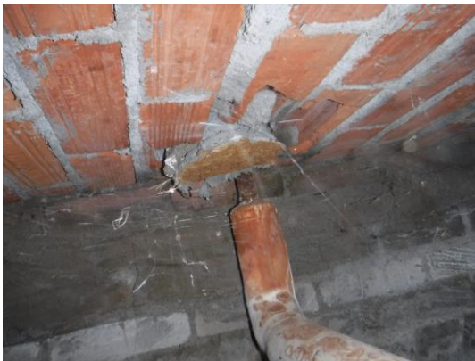
De vloer bestaat uit een holle baksteen vloer
