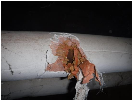
Leidingisolatie niet asbestverdacht
