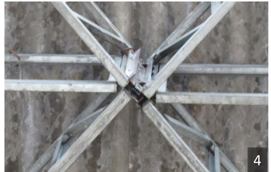
Aangepaste verbinding van de dakconstructie (extra L-profielen gelast)
