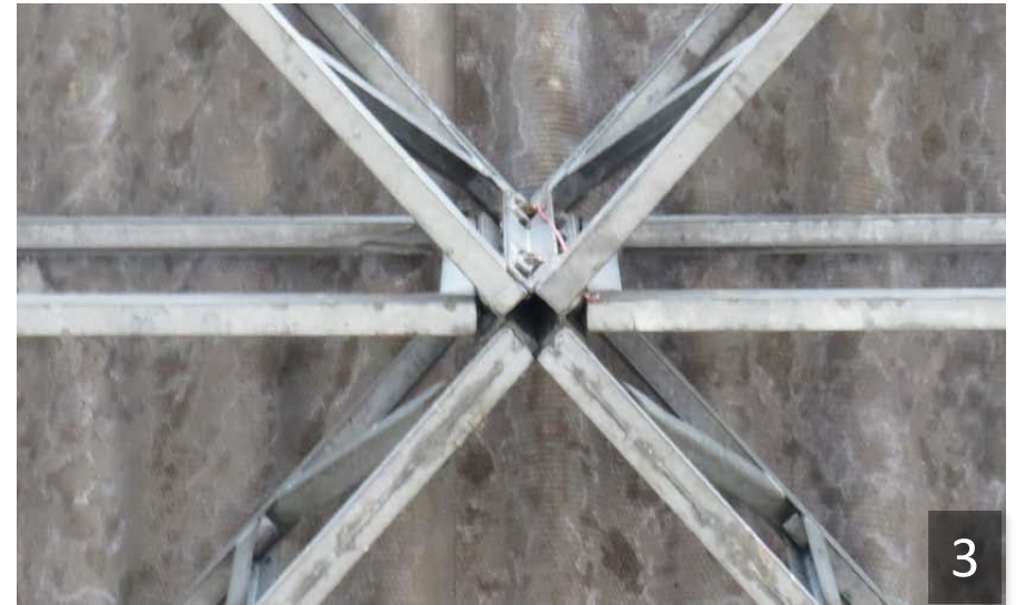
Oorspronkelijke verbinding van de dakconstructie (gebout)
