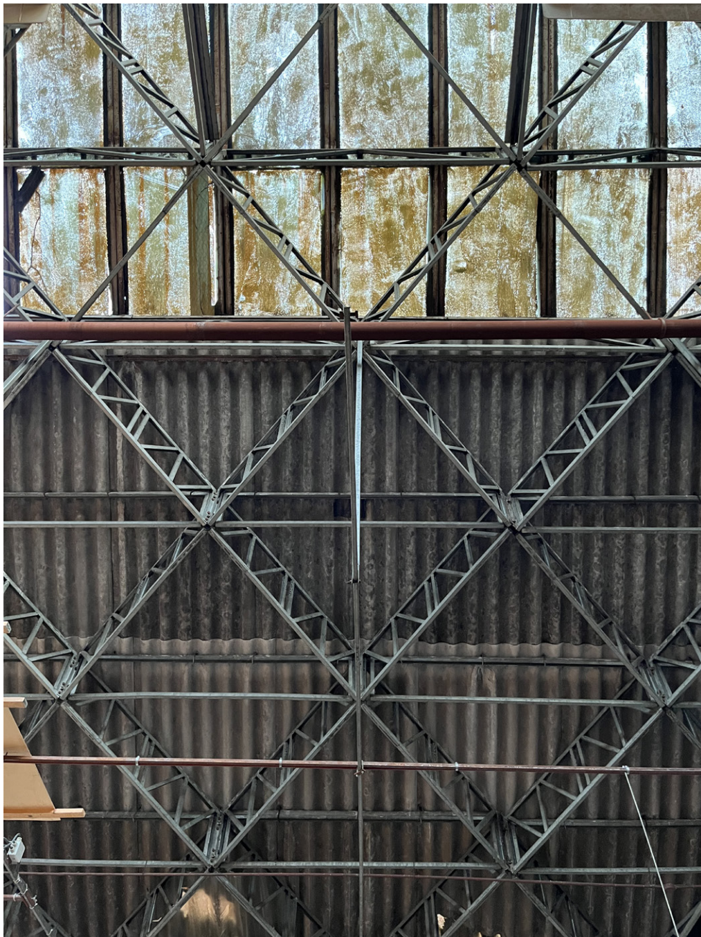
Situatie voor het verwijderen van de asbest golfplaten.
