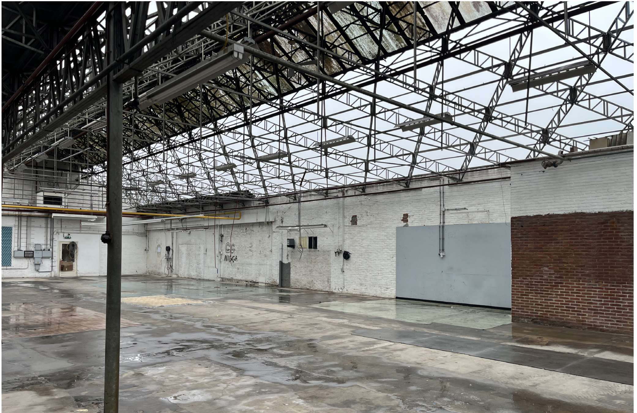
Situatie na het verwijderen van de asbest golfplaten.
