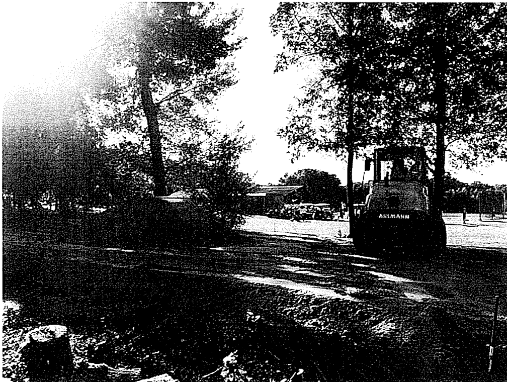
Foto zijkant met zandpakket hoogte
