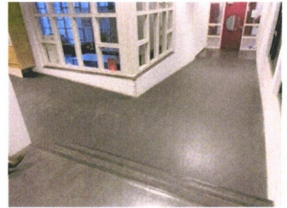
Verkeersruimte in het Holleblok met treetjes, en hellingbanen. Niet geschikt voor minder mobiele mensen.
