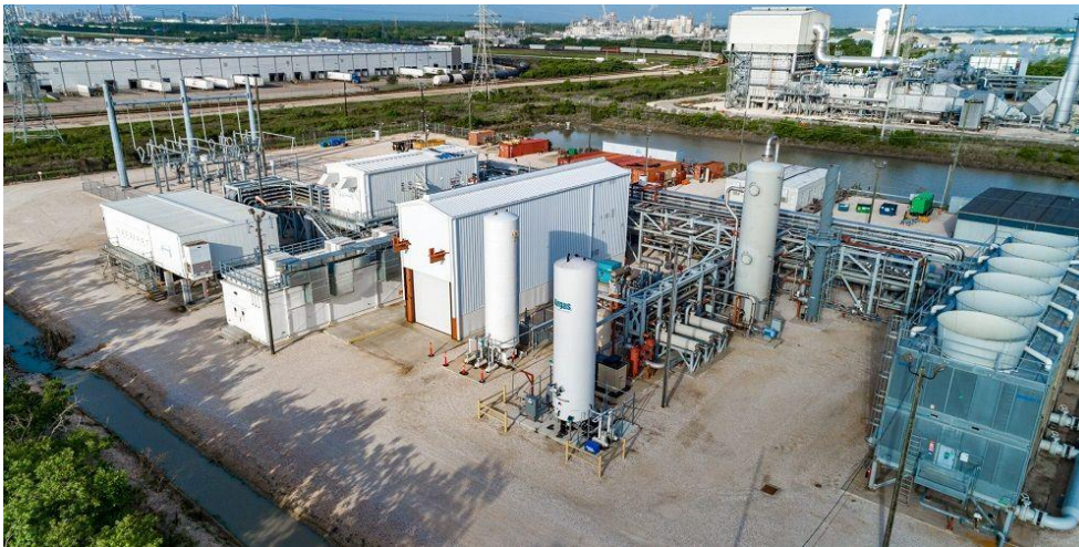
De gascentrale met geen NO x uitstoot. Geen schoorsteen te zien!
